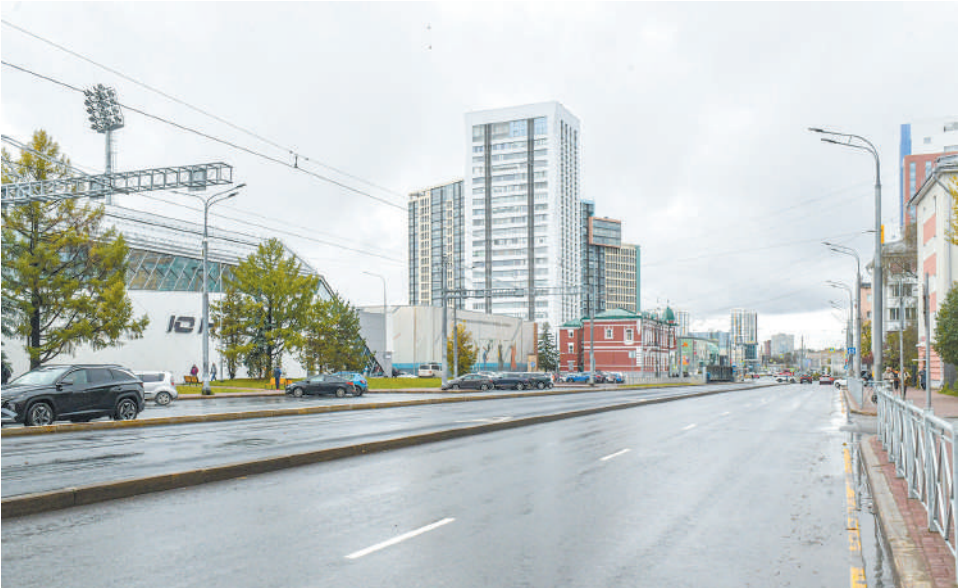
Ул. Революции от Комсомольского проспекта до ул. Сибирской Вдоль отремонтированного участка располагается стадион «Юность» – один из центральных спортивных объектов города. В конце 2025 года комплекс обновили в ходе масштабной реконструкции.
