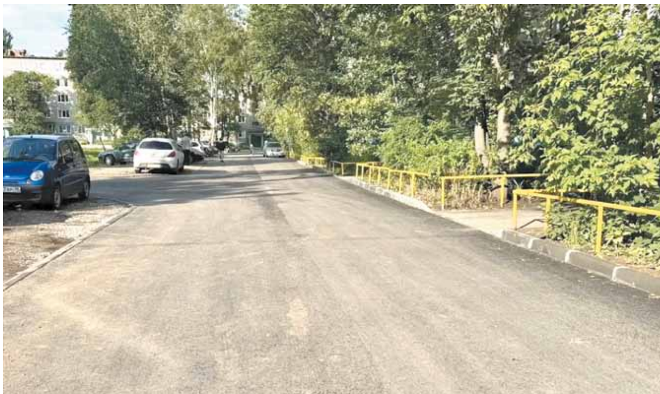
Отремонтированный проезд во дворе дома по ул. Архитектора Свизева, 42
